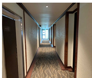
Before【新設エレベーター①】
