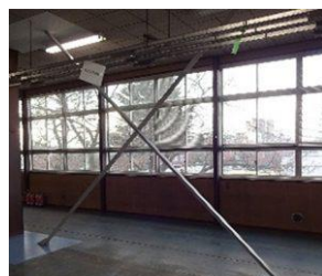
完了 内部 2階事務所・作業場
