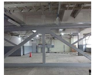
完了 内部 1階 工場・倉庫
