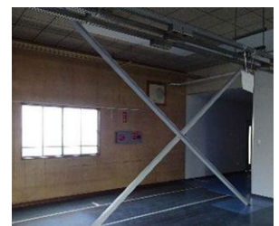
内部 2階事務所・作業場
