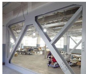
完了 内部 1階 工場・倉庫
