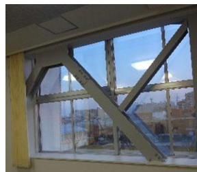
完了 内部 階段室
