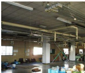
着工前 内部 1階 工場・倉庫
