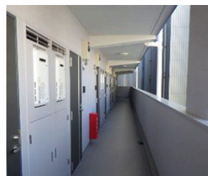
改修後(共用廊下)
