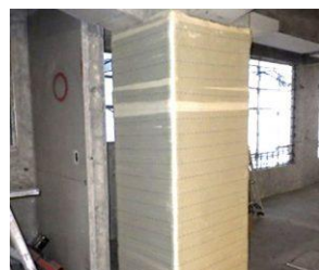
耐震補強(SRF工法)
