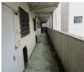
改修前(共用廊下)
