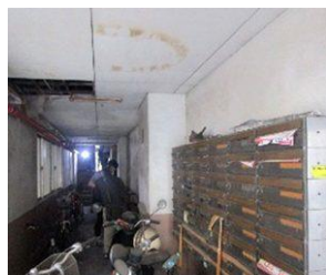
改修前(エントランス)
