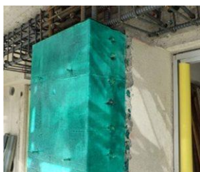
耐震補強(ハイパー工法)
