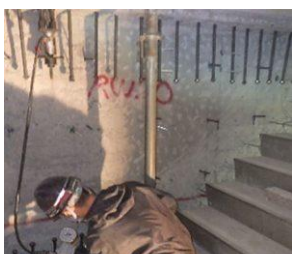
BEFORE【壁耐震補強配筋】
