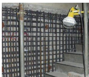
AFTER【壁耐震補強配筋完了】
