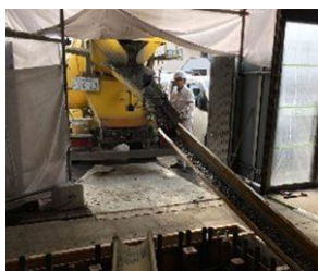
新設ピットコンクリート打設
