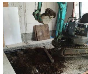
新設ピット掘削
