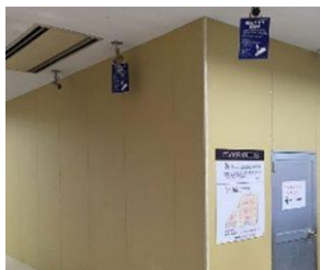
工所用仮囲い設置
