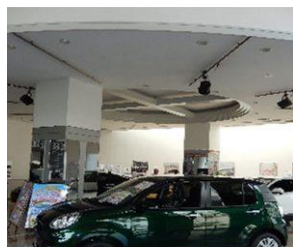
ラウンジ(施工前)
