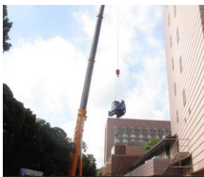
400tトラック搬入(駐車場)
